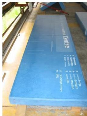
*Éléments en béton bleu teinté dans la masse et protégé avec anti-graffiti permanent*
