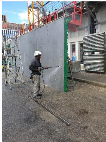
*Les banches doivent être de bonne qualité et uniforme pour assurer un aspect homogène de la lasure*
